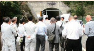
一般県道広畑青山線工事現場
